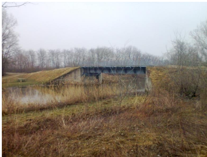
40. ábra: Az új Szentei-híd
