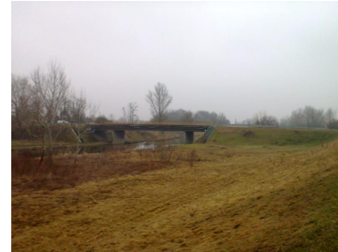
41. ábra: Mórichidai közüti híd
