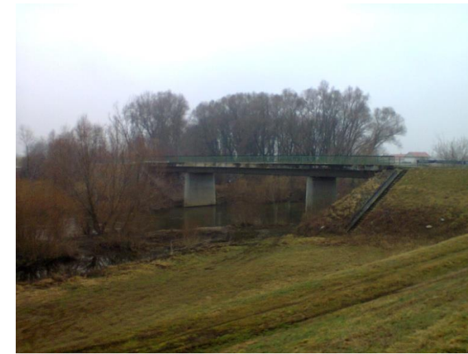
45. ábra: Rábapatonna – Koroncó közúti híd
