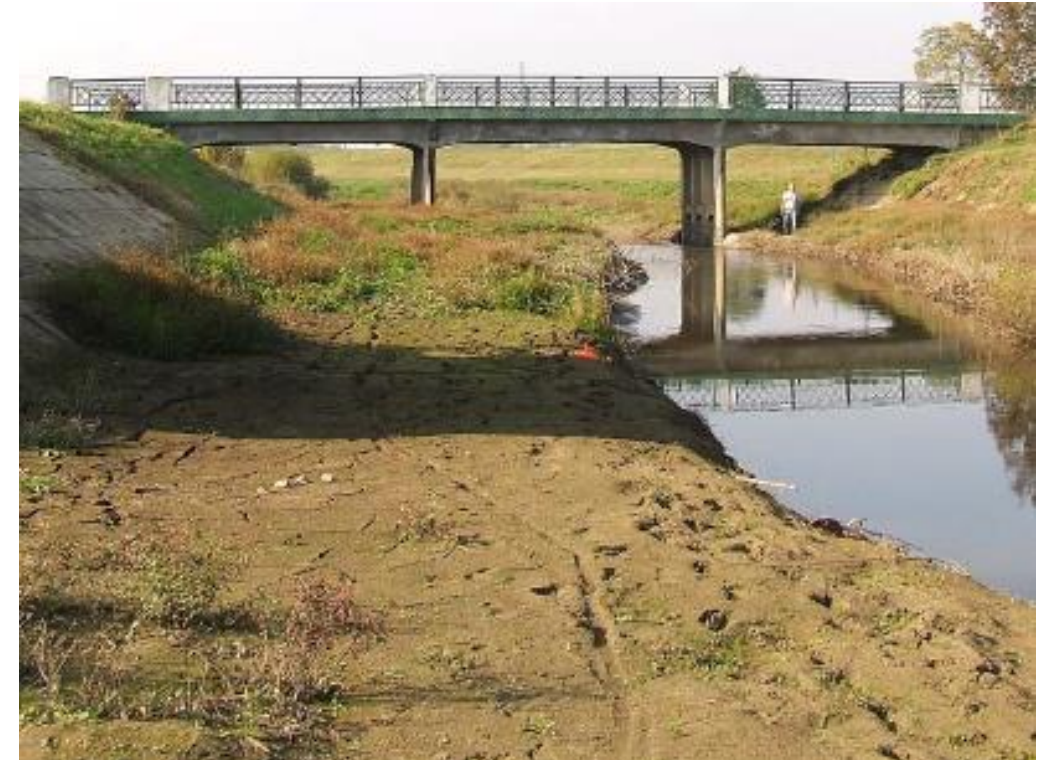
27. ábra: Csánig – Répcelak közúti híd
