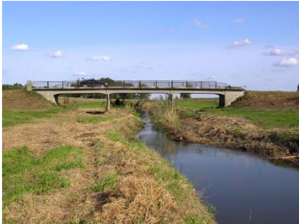
29. ábra: Mezőgazdasági híd a 4+439 fkm szelvényben
